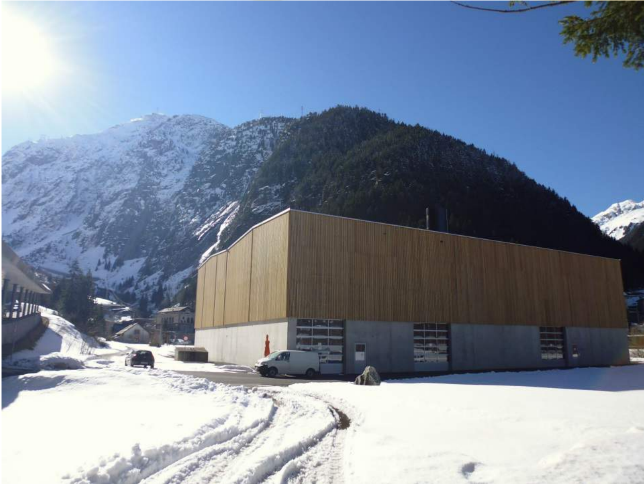
Foto: Heizzentrale Heizwerk Gotthard AG in Göschenen. Quelle: oeko energie ag
