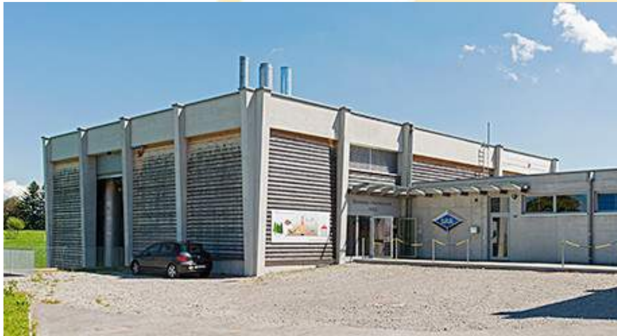
Foto: Heizzentrale Wies der SAK in Speicher. Quelle: SAK
