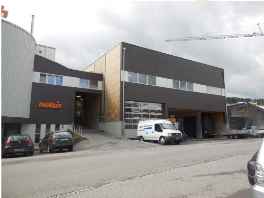
Foto: Heizzentrale der Firma Holzin AG. Quelle: www.klik.ch
