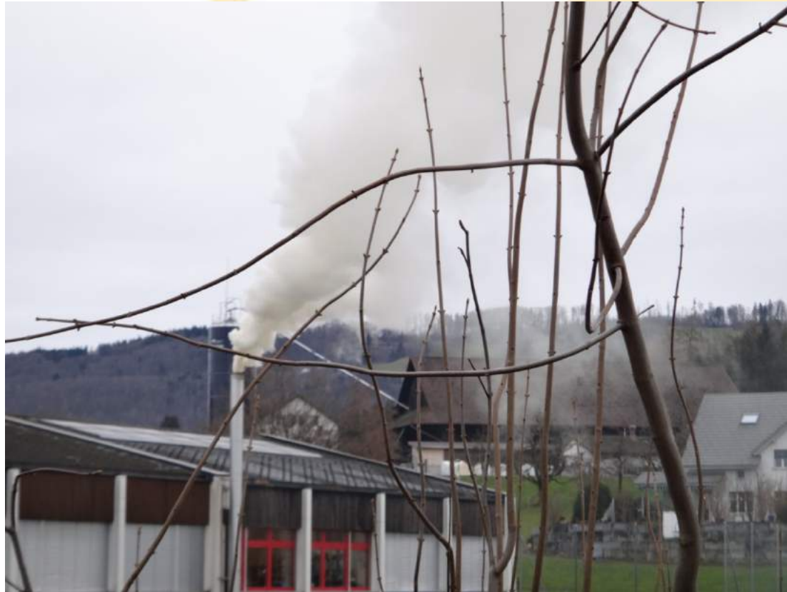
Trockenschnitzelfeuerung Schulhaus Kappel am Albis
