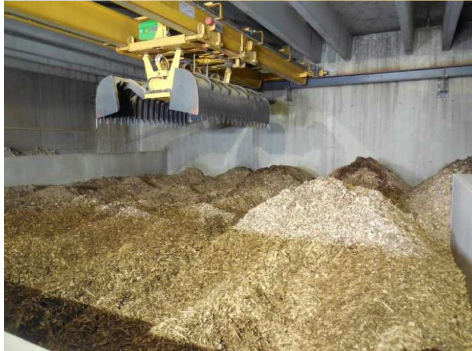
Foto: Schnitzellagerhalle der Firma Holzin AG. Quelle: www.klik.ch
